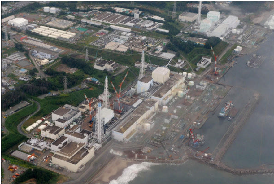
Luftbild der Nuklearanlage von Fukushima mit den vier schwer beschädigten Atomreaktoren (Foto vom August 2013). (Bild: Keystone/AP Kyodo)
